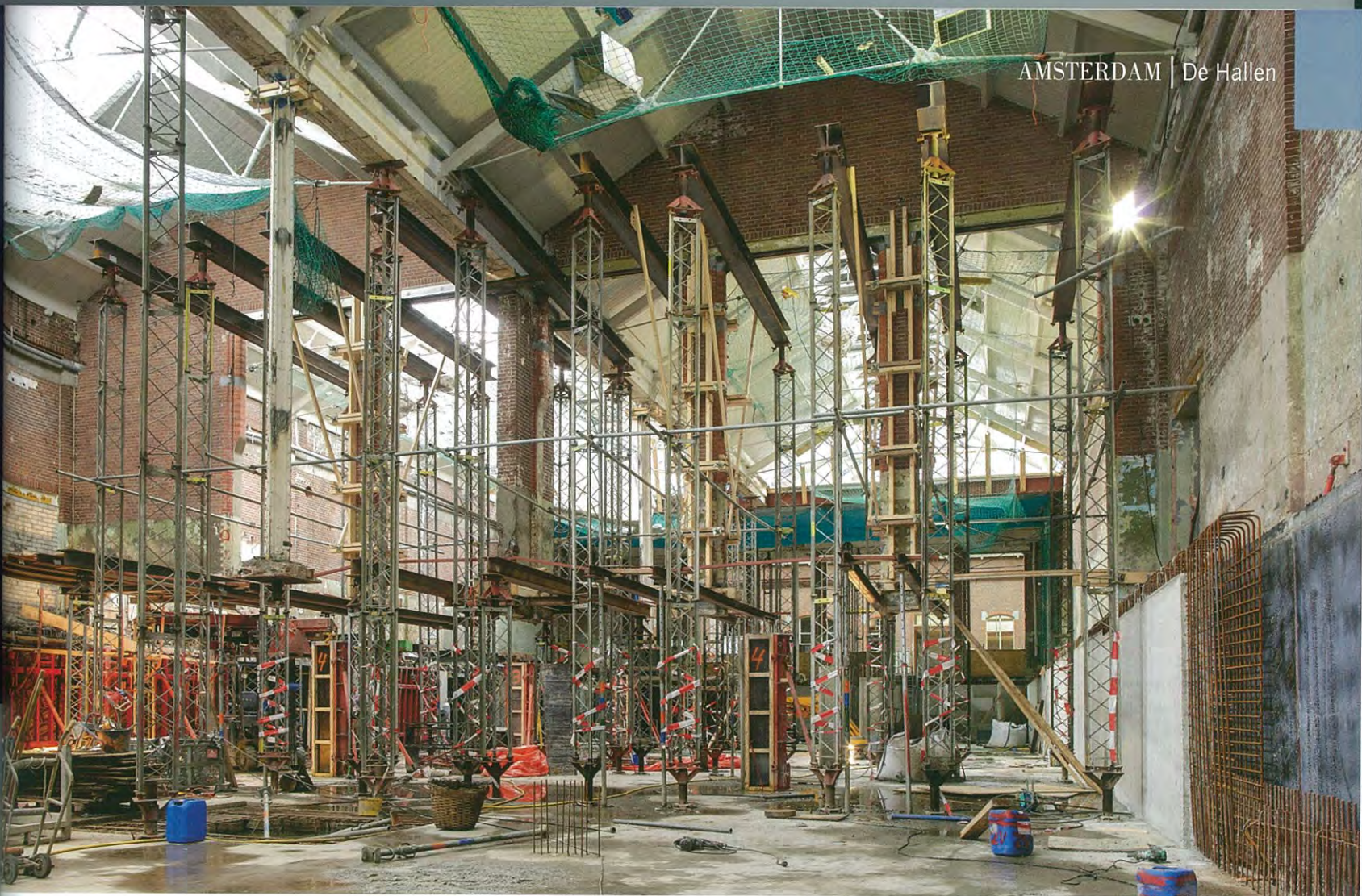
De vloer is uitgegraven tot de bestaande houten palen
