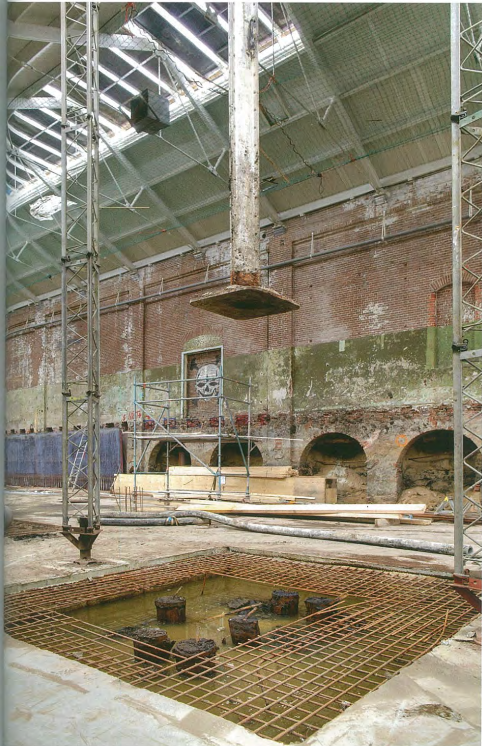
De nieuwe fundering werd aangelegd om de bestaande palen heen
