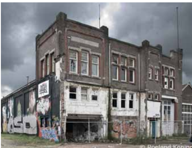
Figuur 22 Achterstallige onderhoud in de Hallen 8
