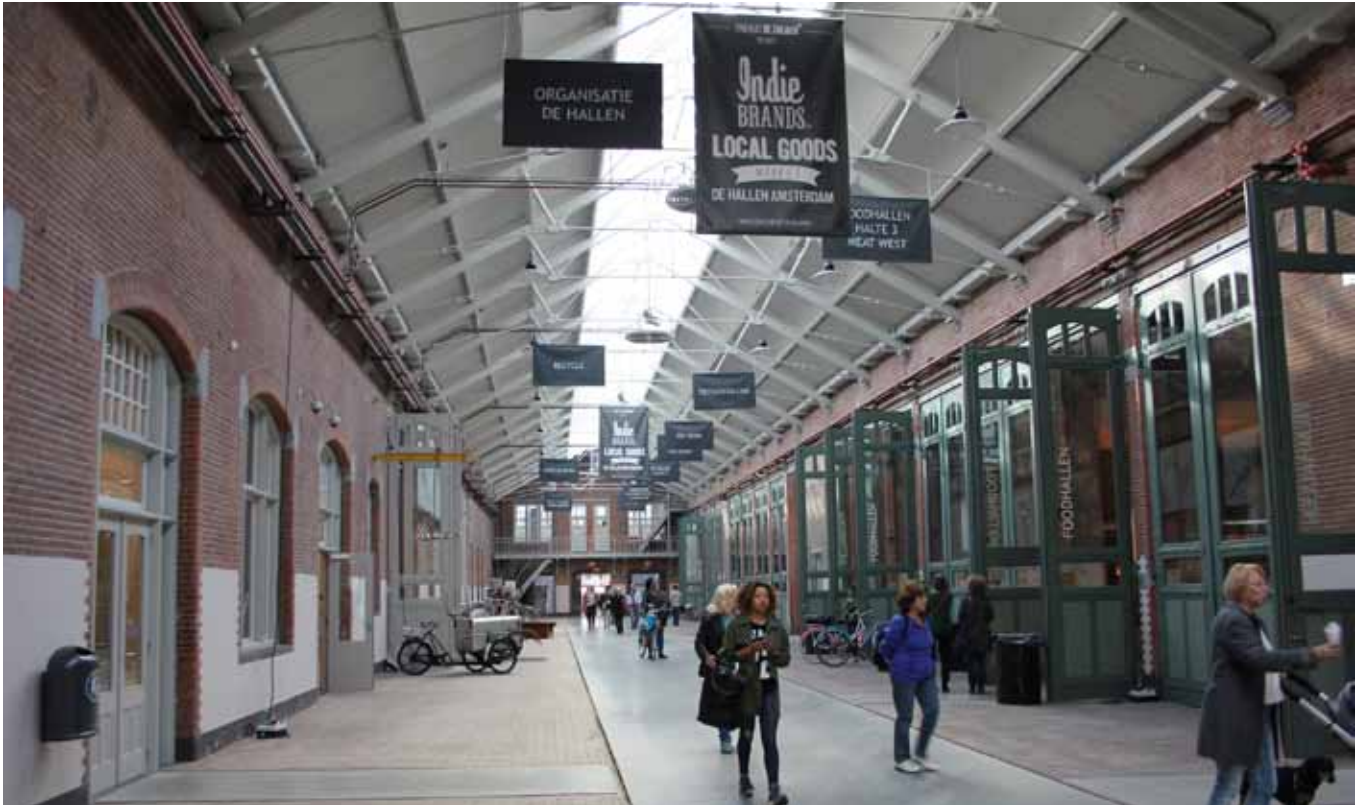
Figuur 19 Entreehal en spanten dakconstructie 5
