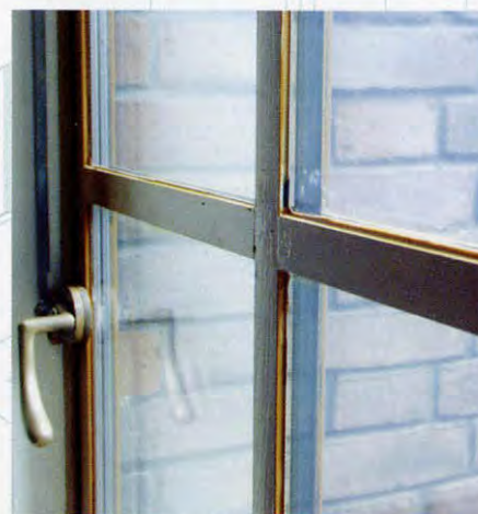
In de karakteristieke ramen komt dubbelglas.
