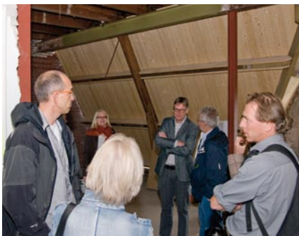
Gerard van Noort (in het midden) op de gerestaureerde zolderruimte van de oorspronkelijke oud-bouw aan de Schreevoogtstraat.
