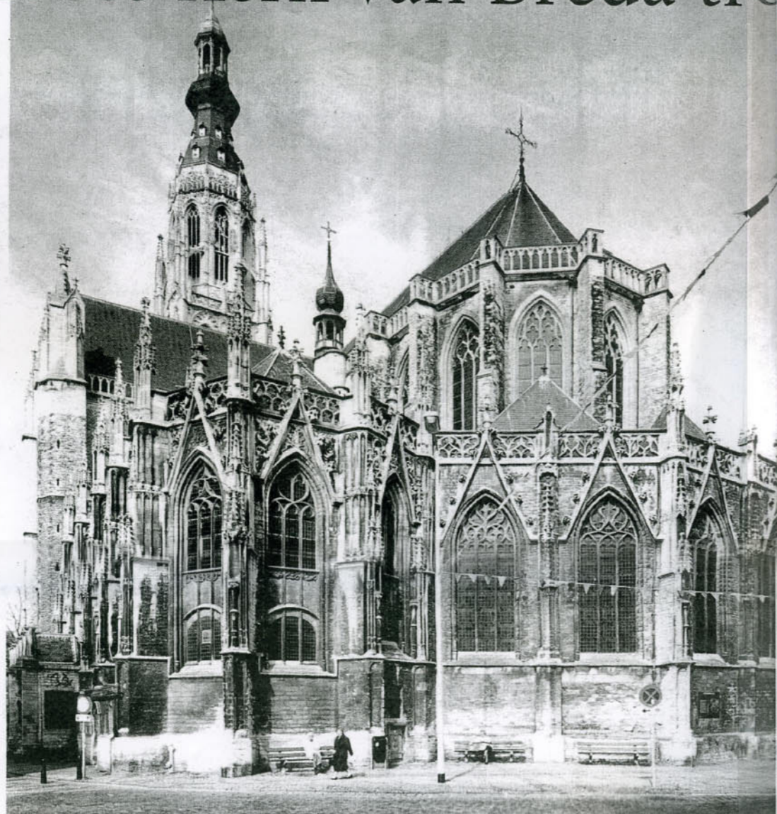
De Grote of O.L.-Vrouwekerk, begin jaren '90. Breda's grootste kunstschat oogde vervuld en verveerd en bleek door vocht zwaar aangetast. De natuurstenen balustrades waren bijvoorbeeld zo poreus geworden, dat ze met gas en ijzerdraad bij elkaar gehouden moesten worden.
