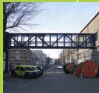
De loopbrug tussen gebouw B en gebouw A wordt gesloopt
