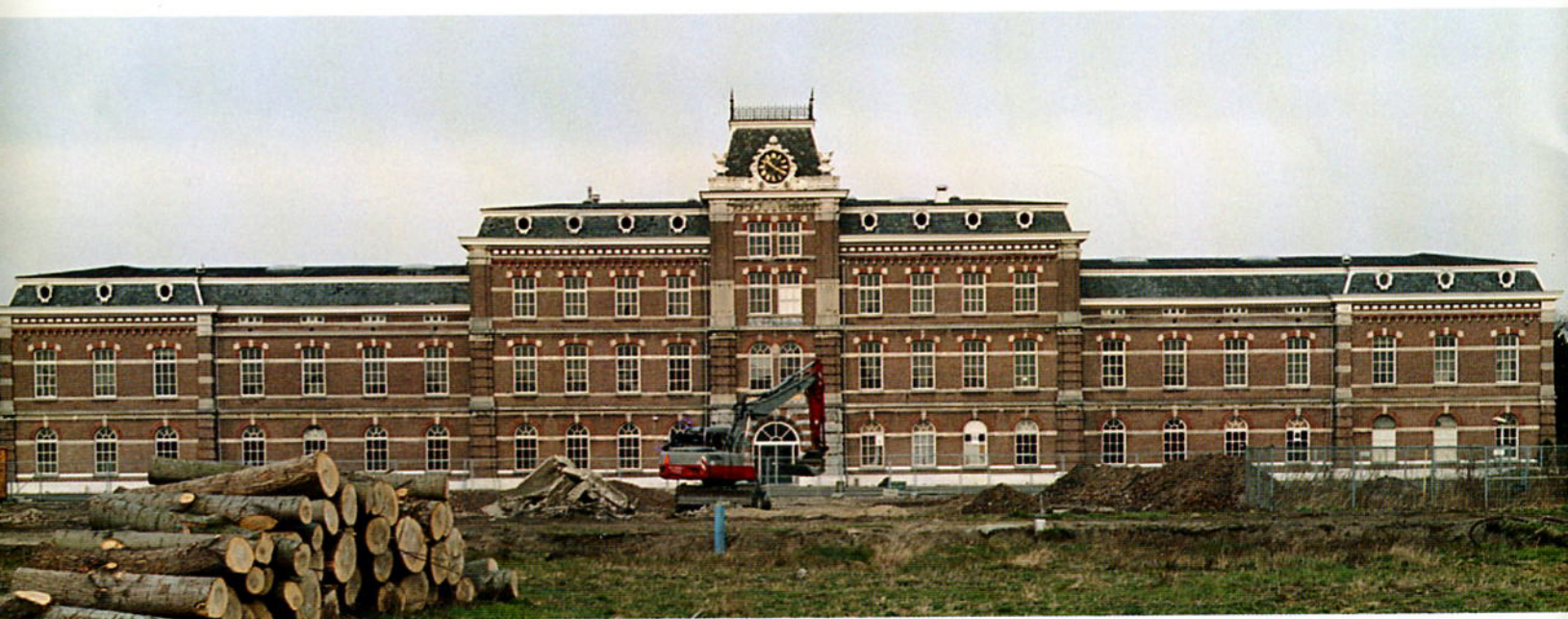
het bouwrijp maken van het terrein is in volle gang
